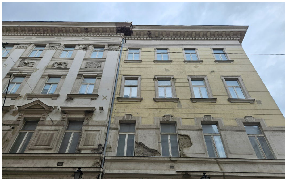
Tüköry utca felőli homlokzat
