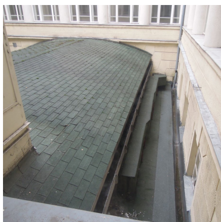
Beépített fűdvar utólagos tetőfedése
