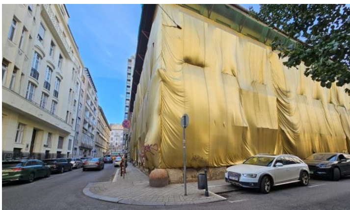
Szép utca 6. szám alatti épület látványa (forrás: saját fotó)
