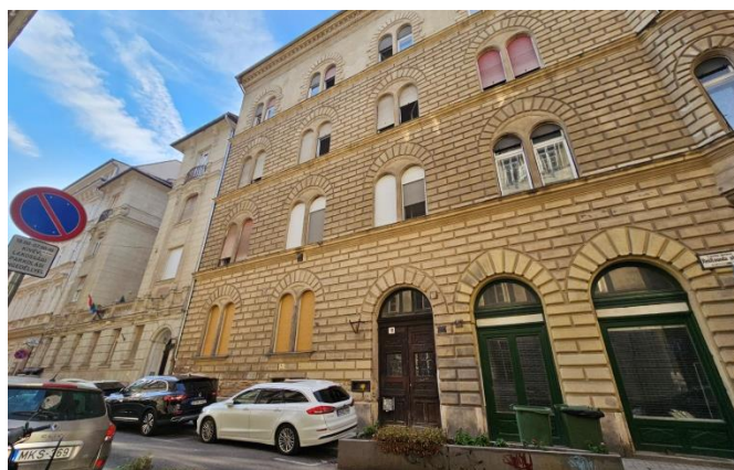
Reáltanoda utca 18. – mögötte az nyitott udvaros épülettel (forrás: saját fotó)
